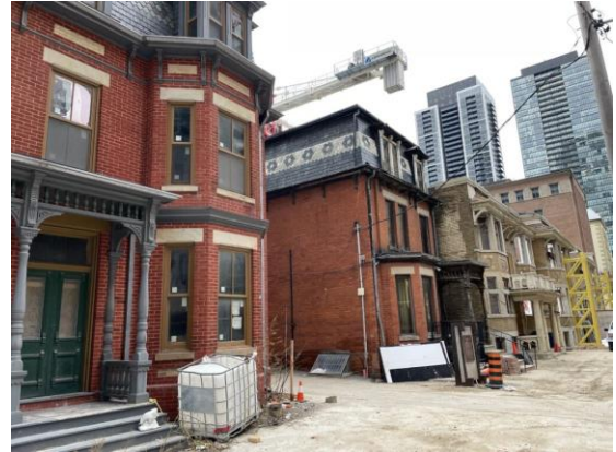
Tout le coin Charles et Church est en construction
