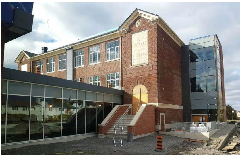
Travaux de construction de la Maison de la francophonie d'Ottawa, en 2019 © CMFO
