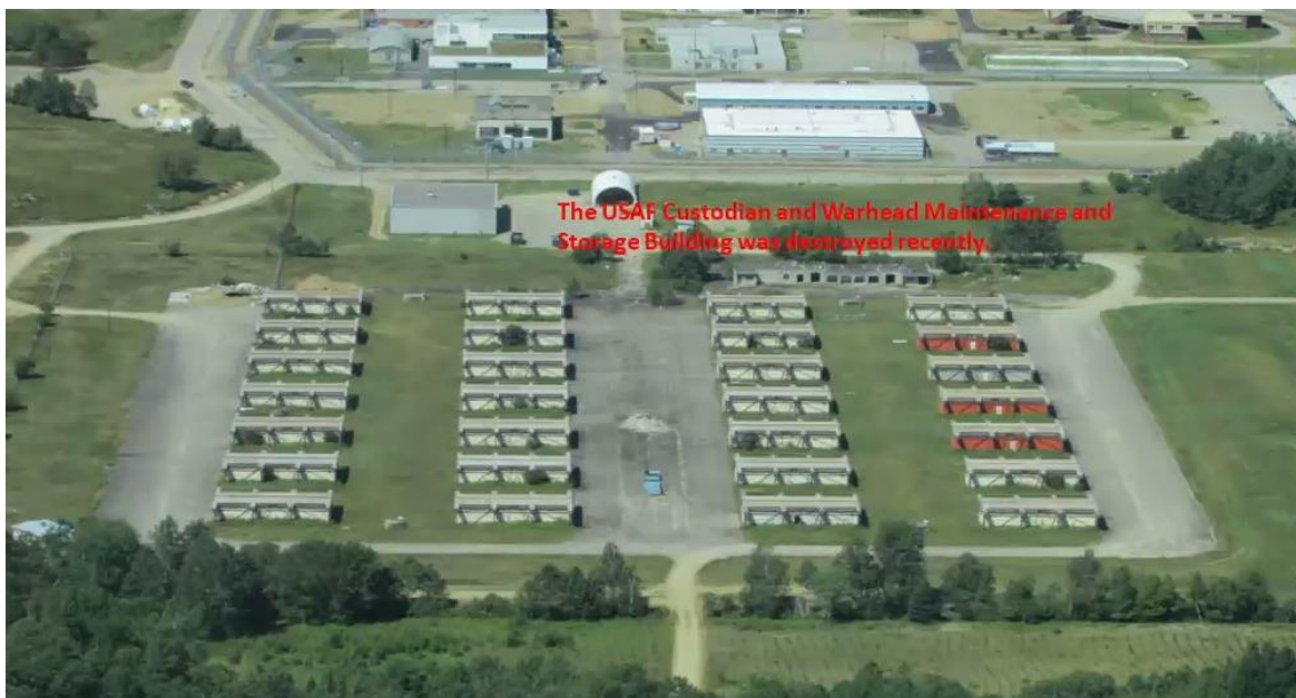
Les 28 abris de missiles sont inopérants. Photo : Benoît Thibeault.
